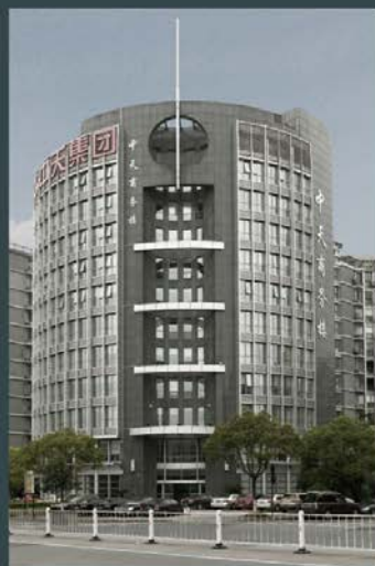
杭州 中天商务楼 (2004-2012)
